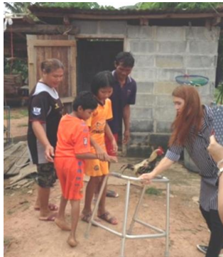
予定工事①スロープ作り トイレ建物までのスロープを作り、歩行器で移動しやすくなります
