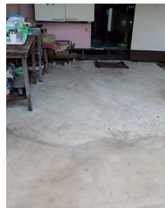
バリアフリー工事後の自宅玄関前
