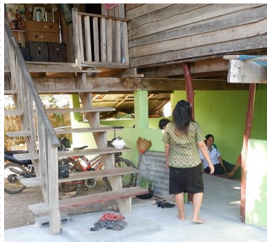
完成した1階の部屋と2階への階段
